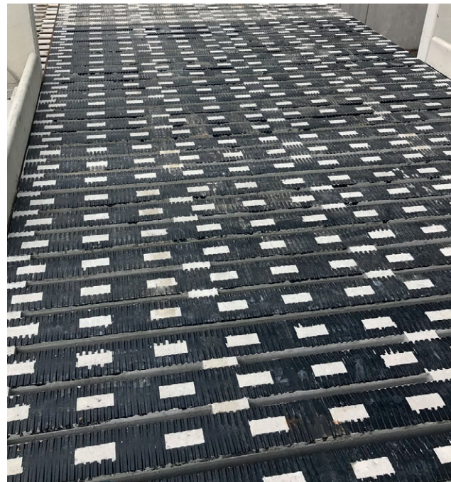
Halteklötzchen aus faserverstärkten Beton.
